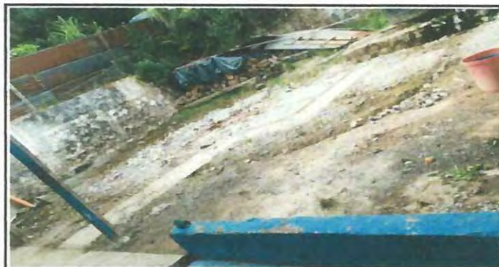
Foto 9: LOSA DE PATIO PARA RECREACION DE NIÑOS
