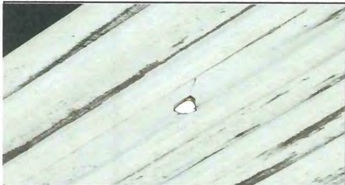
Foto 7: CAMBIO DE LAMINAS ROTAS, AUGERIADAS, RAJADAS
