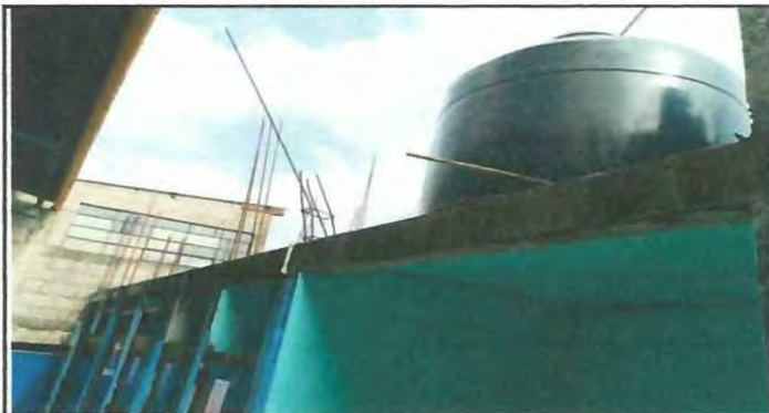
Foto 13: REUBICACIÓN DE DOS TINACOS PARA EL AREA DE BAÑOS ABASTECIENDO A BAÑOS Y UNA PILA
