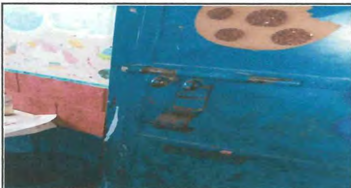
Foto 15: CAMBIO E INSTALACIÓN DE CHAPAS
