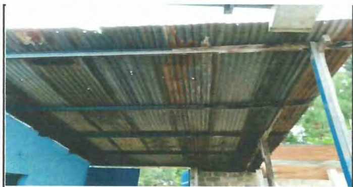
Foto 11: CAMBIO DE TECHO Y MADERA POR LAMINA TOQUELADA Y TUBOS DE METAL
