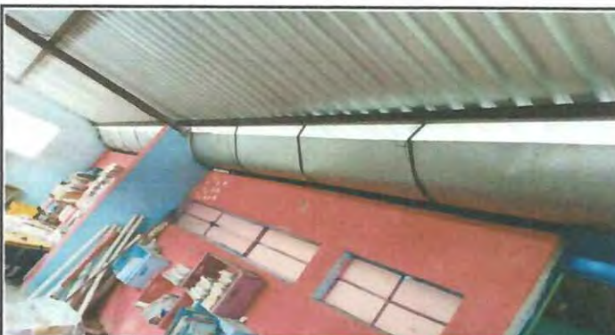
Foto 8: REAJUSTE DE CANAL Y REDIMENSIONAMIENTO DEL MISMO
