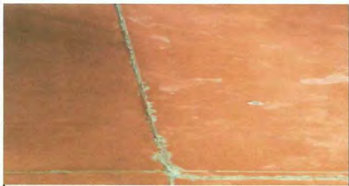
Foto 5: CAMBIO DE PISO ENTORTADO A CERAMICO SE ENCUENTRA YA DAÑADOS Y RAJADOS GRAN SALON
