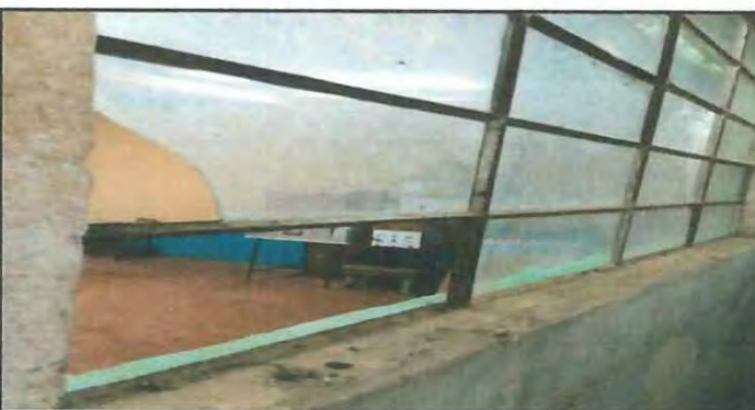
Foto 10: CAMBIO DE VIDRIOS ROTOS O QUEBRADOS
