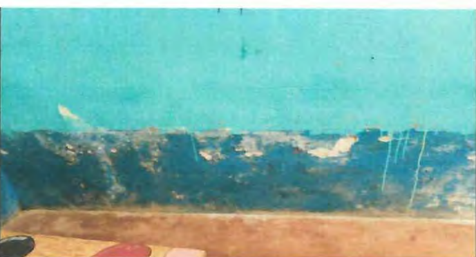
Foto 12: REPELLO DE PARED DEL AULA DE CECODII ESTA MUY DETERIORADA
