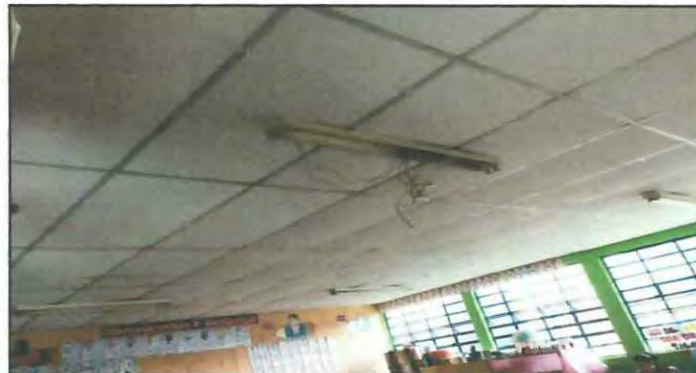
Foto 14: CAMBIO DE FOCOS Y LAMPARAS A FOCOS
